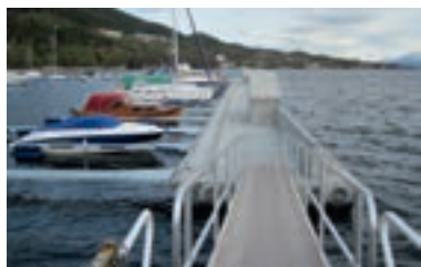
Bølgedemper som gir småbåthavn og lagringsboder under vann "på kjøpet".
